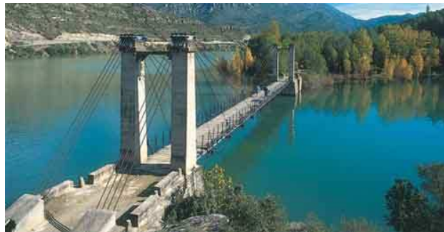
Tirantes del puente sometidos a tracción
