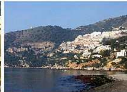
Construcción en acantilado
